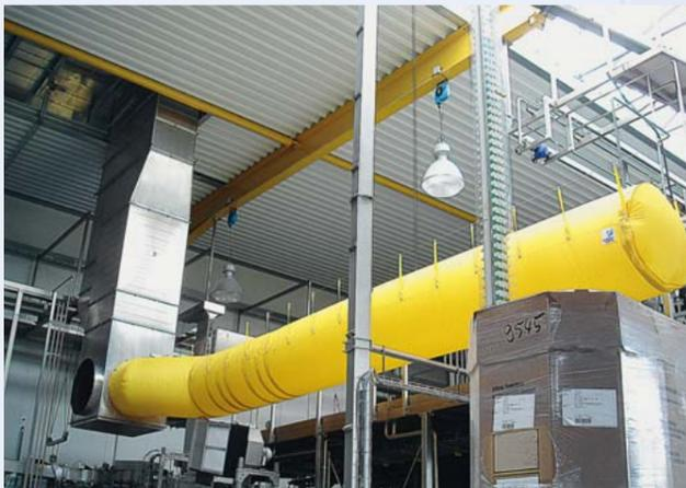
Textiles Luftverteilsystem Typ Perfo-Injekt mit individueller Farbgestaltung und Laserlochung, Abhängung mit Stahlseil. Zur Reinigung leicht de- und remontierbar
