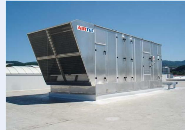
Zuluft – Dachzentrale auf Dachsockel (nach unten komplett offen)
