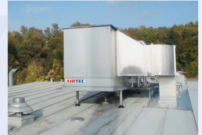
Ansicht Dachzentrale / Dachdurchdringung, montiert auf Rahmen-Ständerwerk
